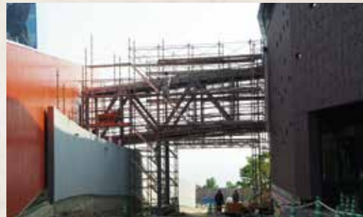
新館と本館をつなぐ連絡通路の形が見え始めました。(2017年10月11日)
