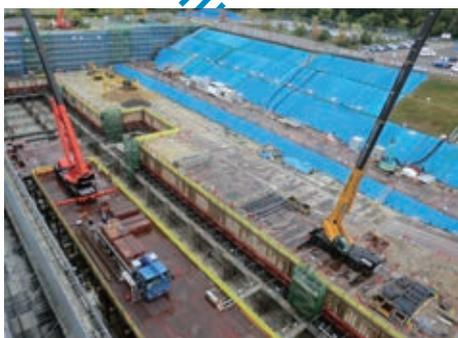
クレーン車で乗入れ構台を設置している様子
