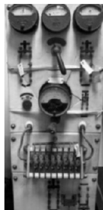
写真3.13 パネル型瞬減火花送信機（通信総合博物館所蔵） 15
