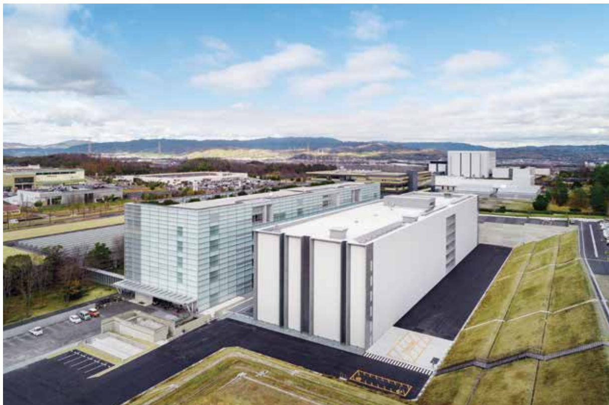
写真10 関西館書庫棟（令和2年2月竣工）
