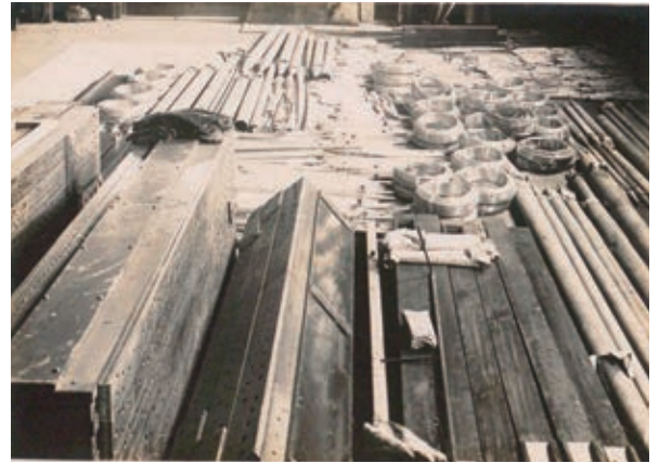
床に並べられたパイプオルガンの部品。写真奥に見えるのは金属製のパイプと、巻かれた送風管。手前側には、風箱（パイプを挿す箱。左側）と木製のパイプ（右側）が見える。南葵楽堂のパイプオルガンには約1,400本のパイプが用いられている。
