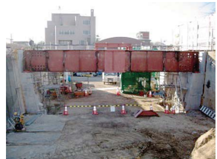
図3 旧式橋梁(補強前)
