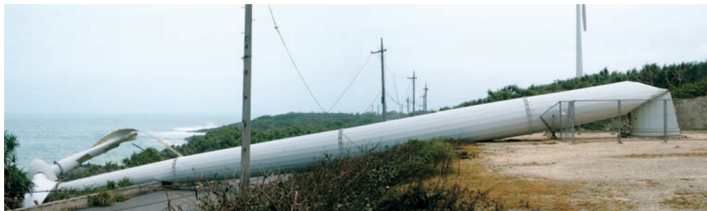
台風第14号により倒壊した風力発電機（宮古島西平安名崎、平成15年9月12日撮影）
