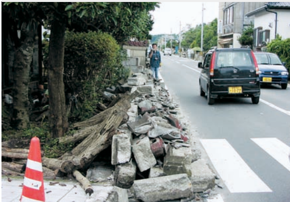
宮城県北部の地震による塀の倒壊 （宮城県河南町新田，平成15年7月27日撮影）
