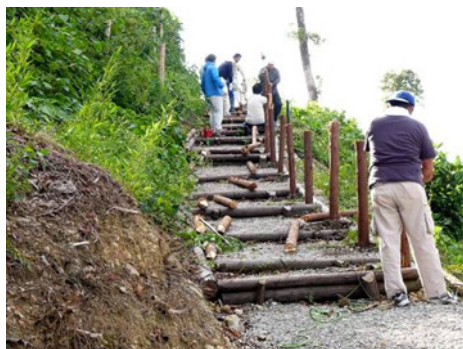
手すり取り付けの様子
