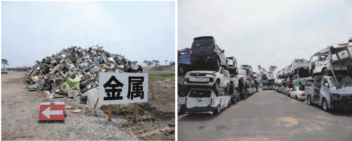
(注) 搬入場内は廃棄物の種類ごとに細かく分けられている。火災防止のため、積み上げは5m以下とされている。左の写真は金属くずで、このように掲示板を掲げて分類を明示し、これに従って運び込まれたがれきが積まれていく。右の写真は被災自動車で、3か所の搬入場のうち蒲生地区のみで保管されており、所有者の意向確認の上、所有者への引渡し、リサイクル等の措置を行う。
