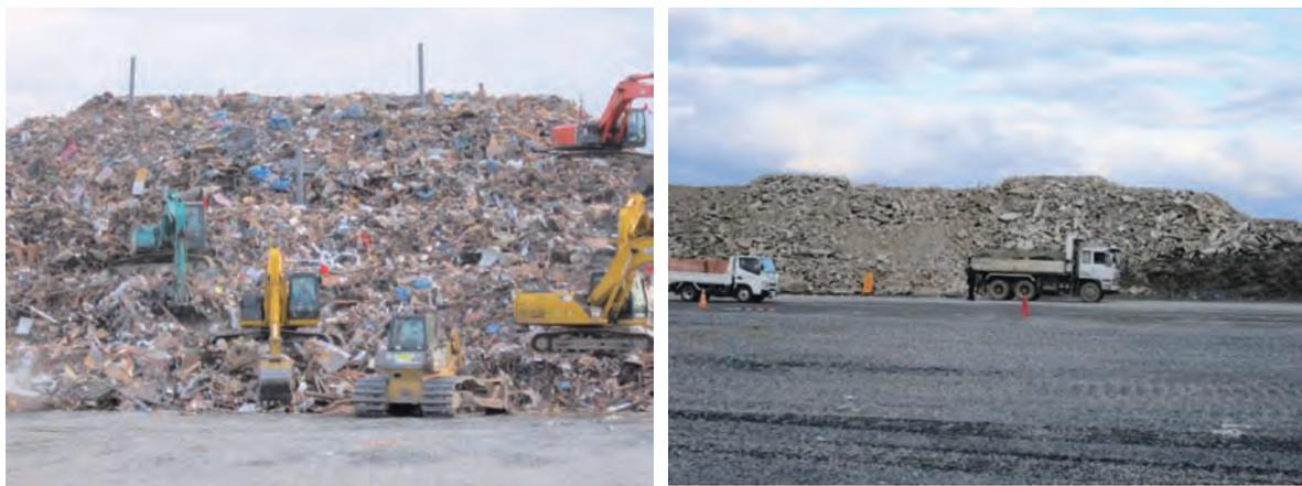
(注) 左の写真は混合ごみで、木くず、金属くずなど複数の種類が含まれることから火災が起きやすいとされており、それを防ぐためのガス抜き管が所々に立てられている。右の写真はコンクリートがら。平成23年12月2日筆者撮影。
