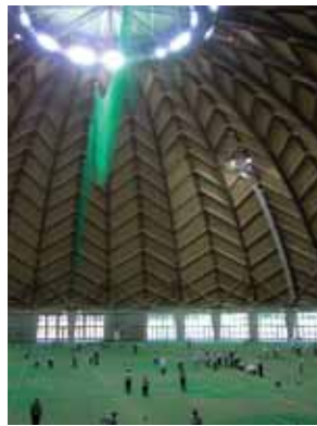
構造材にカラマツ集成材を用いたやまびこドーム
