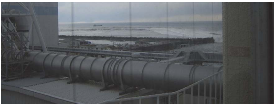
写真 2. 2. 3-4 (exif情報上の撮影時刻は15時41分58秒) 東電より提供
