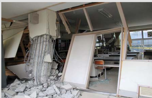
柱や壁の崩壊(旧耐震基準で建築された学校施設)
