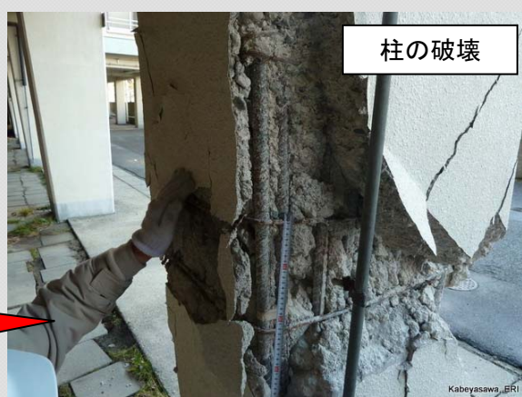
耐震補強済の部分と未補強の部分との被害状況の比較 (未補強部分は翌年耐震補強工事を実施する予定であった)
