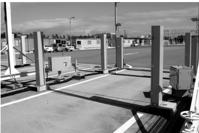
図5 1対の光センサから構成される車両検知器 車両の存在検知を行う車両検知器.
