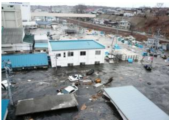
（保安部庁舎東側の状況・JR八戸線が見える）
