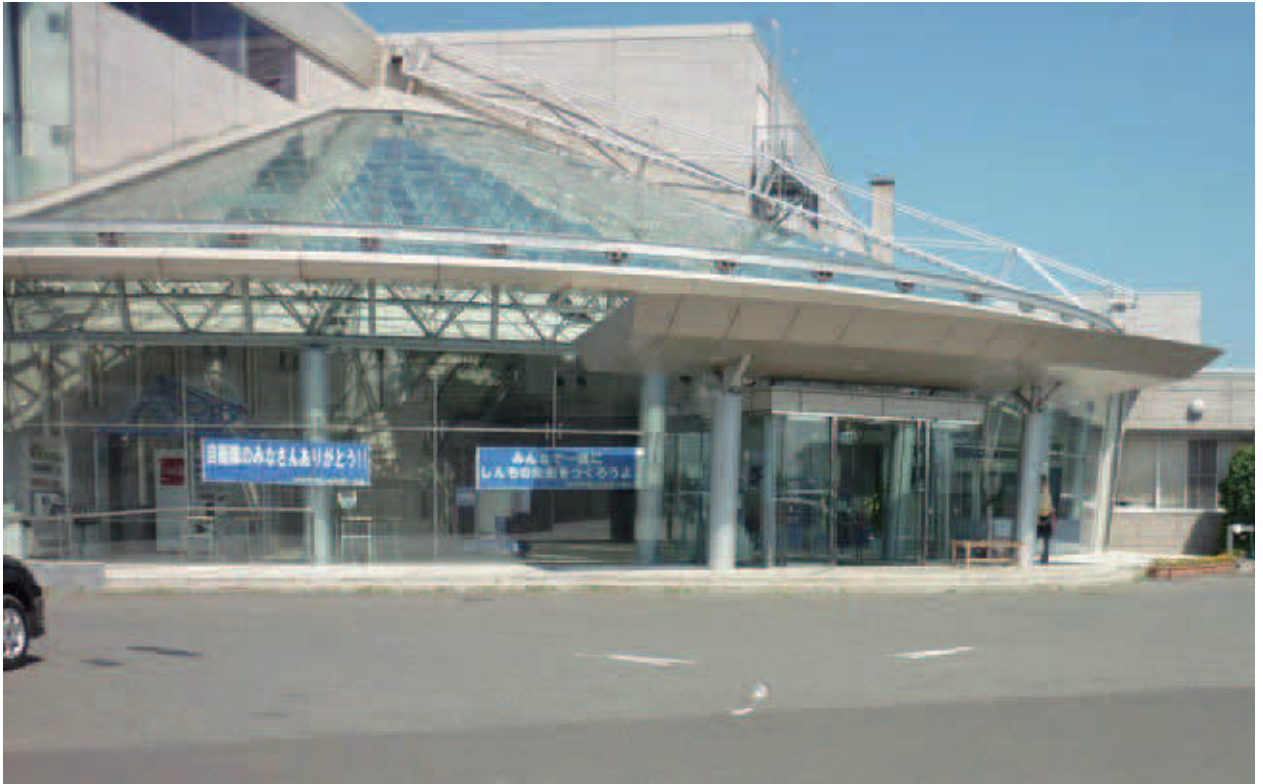
写真4 新地町図書館外観:現在(平成24年9月8日)
