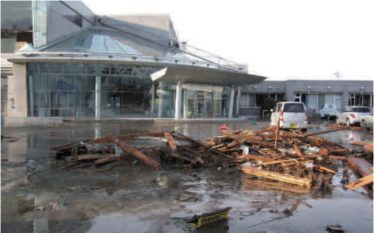
写真3 新地町図書館外観:震災後(平成23年3月11日)
