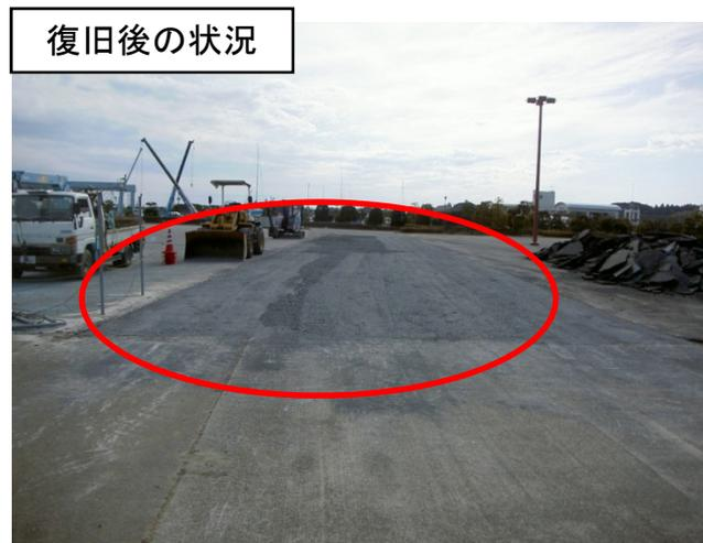
●舗装の撤去、通路の設置(碎石の敷設)
