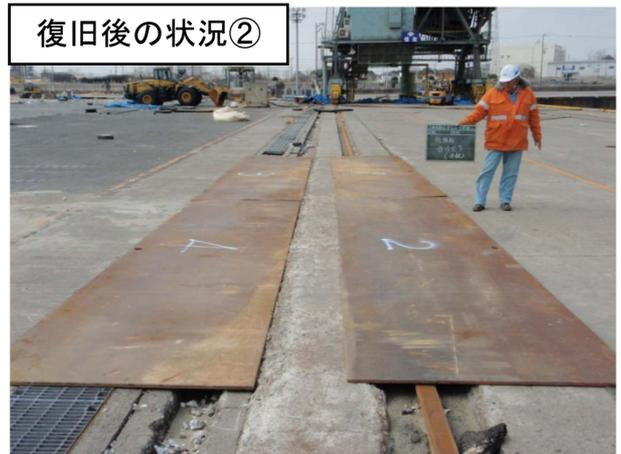
●ヤード内の敷鉄板の設置により段差解消
