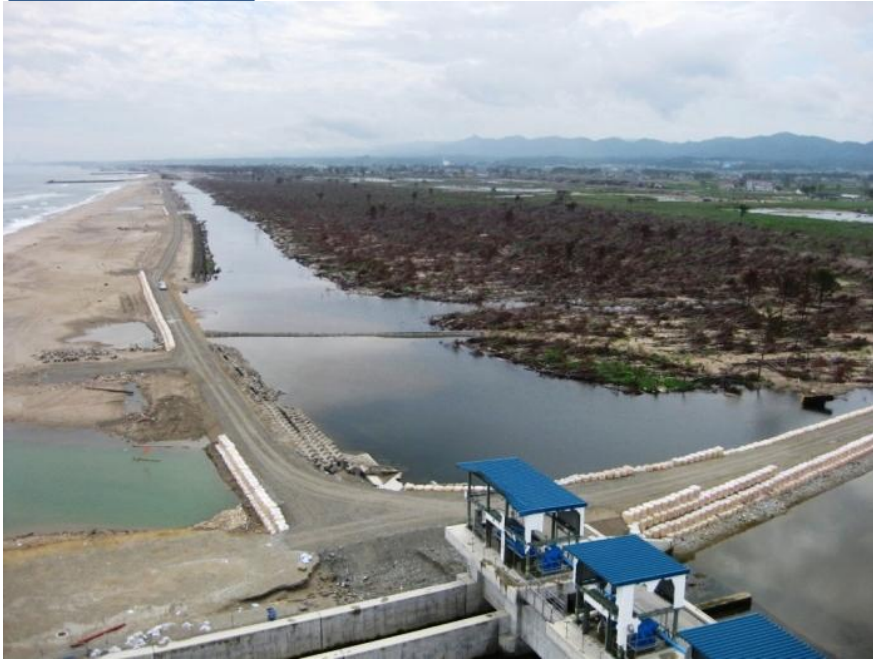
横須賀防潮樋門から南側 須賀海岸被災(山元町)
