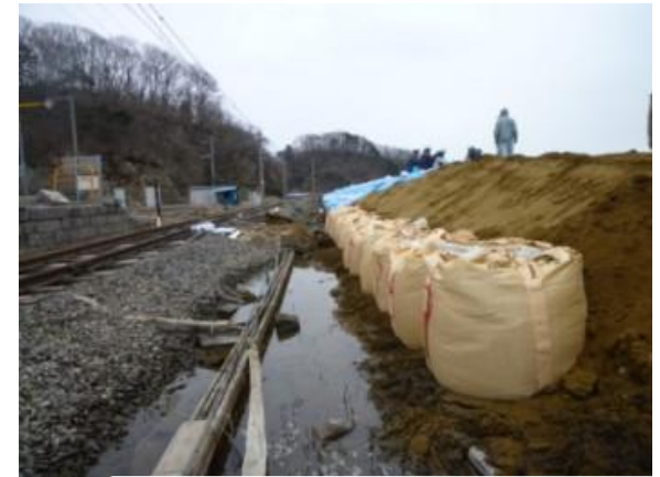
早川海岸応急工事(松島町)
