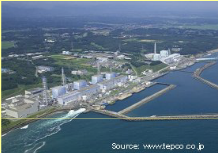
福島第一原子力発電所
