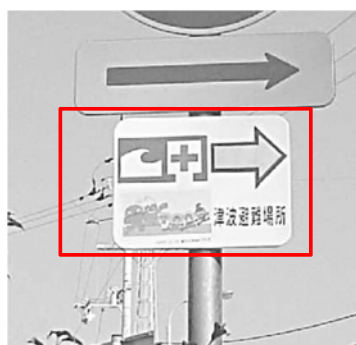
矢印には夜間でも発光する蓄光石、矢印の縁には反射板を使用
