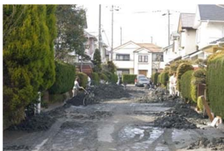
液状化による噴砂(千葉県浦安市) (出典) 浦安市提供
