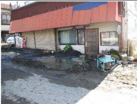
建物への被害(千葉県我孫子市)
