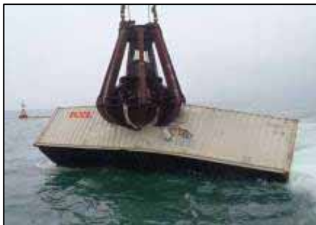
コンテナの引き揚げ作業
