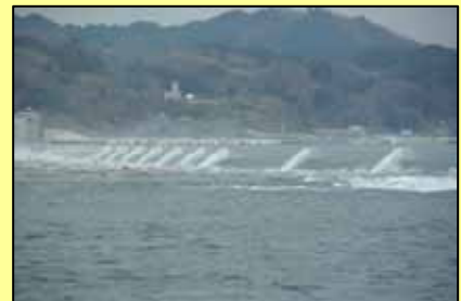
宮古港防波堤を越える津波
