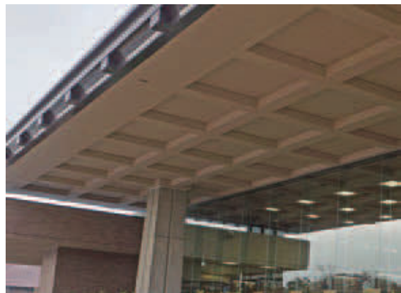
⑦-2 復旧した天井パネル
