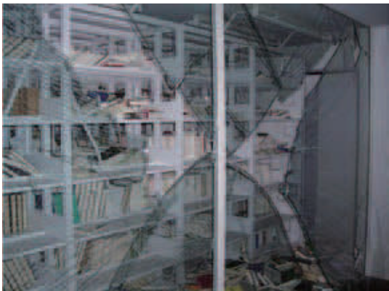
写真⑥-1 宮城県図書館 被災当時の書庫内のガラス壁（宮城県図書館提供）
