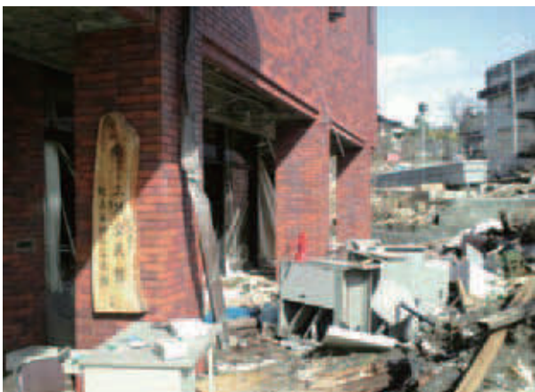
写真③-1 被災当時の大船渡市立三陸公民館図書館 (岩手県立図書館提供)
