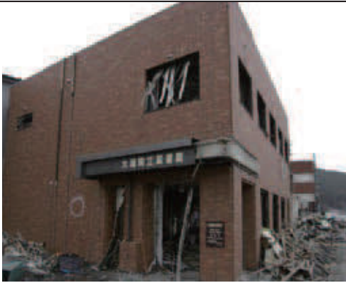
写真①-1 被災当時の大槌町立図書館 (岩手県立図書館提供)
