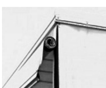
シャッター巻き上げ時の 詳細状態
