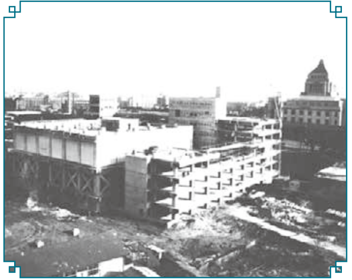
建設中の永田町庁舎（1959）
