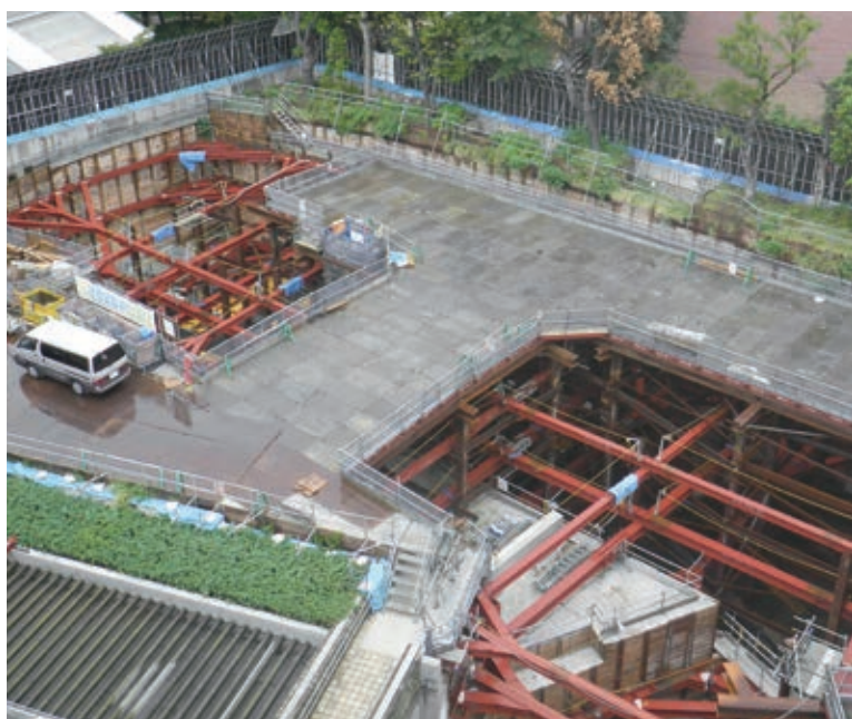
写真6 増築棟建設工事の様子（2013年9月26日撮影）
