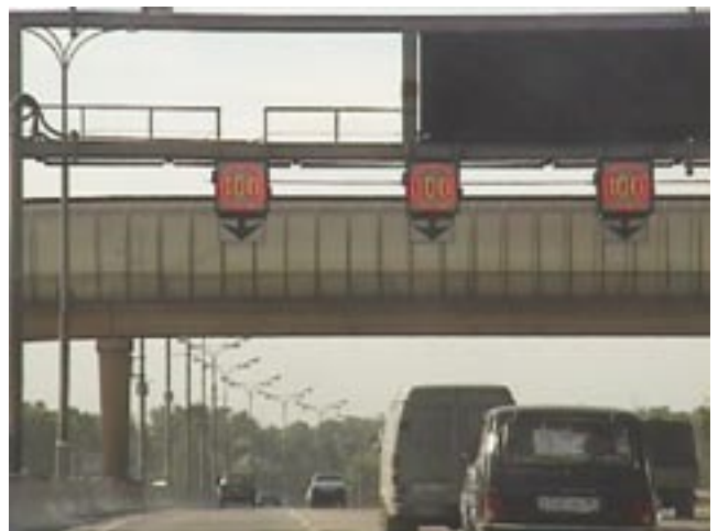
写真－6 可変速度規制システム(モスクワ環状道路) (撮影：著者(宗広))
