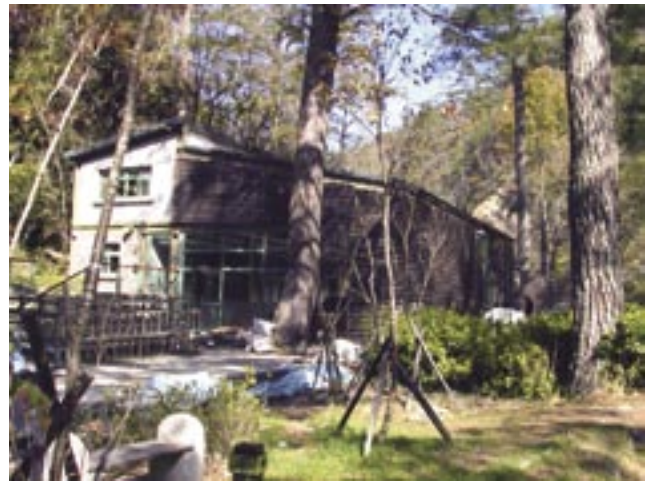
写真-16 建設中の台湾マス孵化施設
