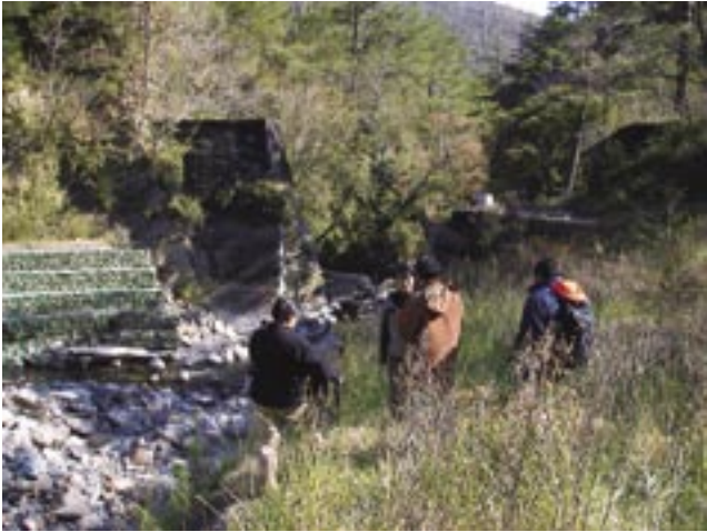
写真-14 武陵溪のスリット化された砂防ダム
