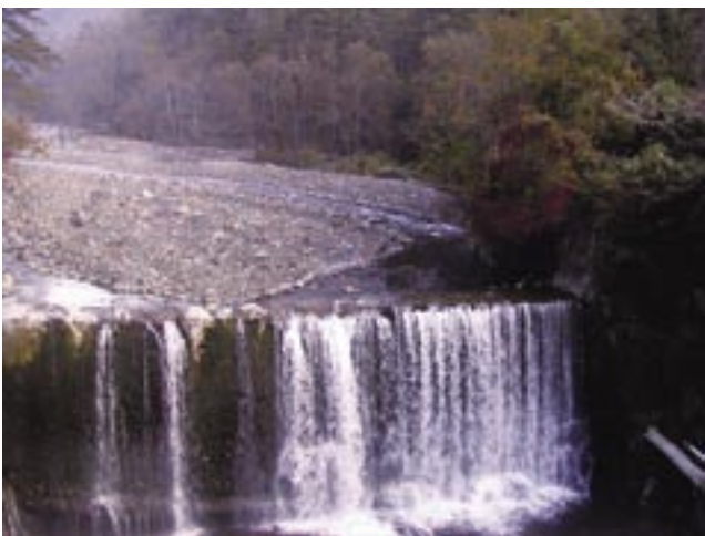
写真-12 第1砂防ダム(武陵管理事務所前)
