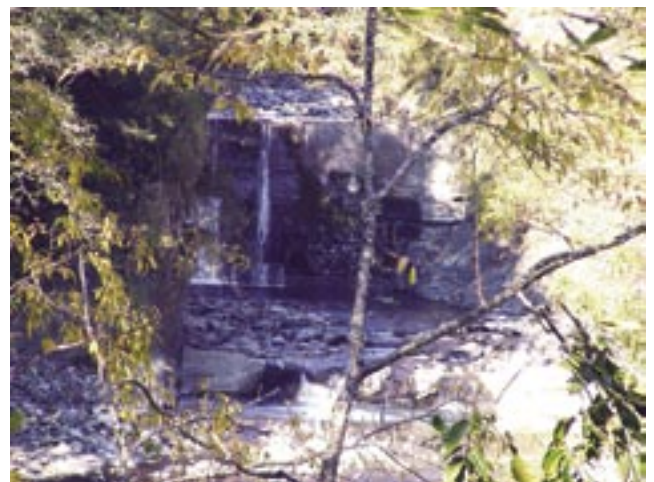
写真-13 第3砂防ダム(上流地点)
