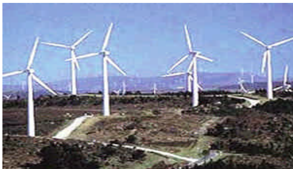
図表2 キューバ、青年の島の風力発電所
