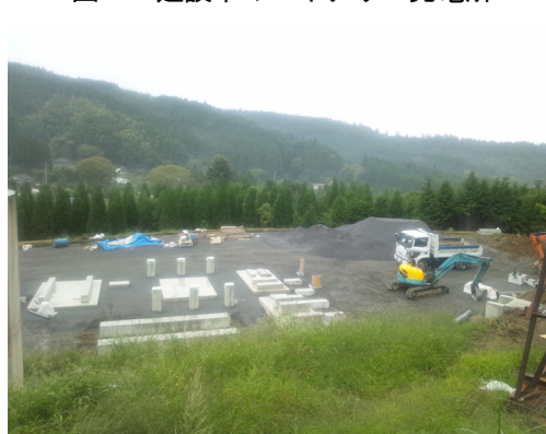
図 6 建設中のバイナリー発電所
