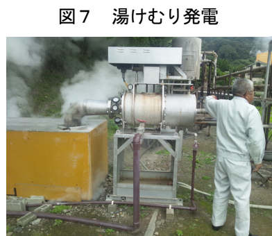
図7 湯けむり発電 (出典) 平成26年10月1日筆者撮影。
