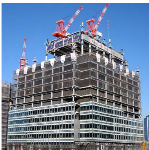
Photo 3 併用型ABC Sによる施工中の建物外観 Building of Project O under Construction
