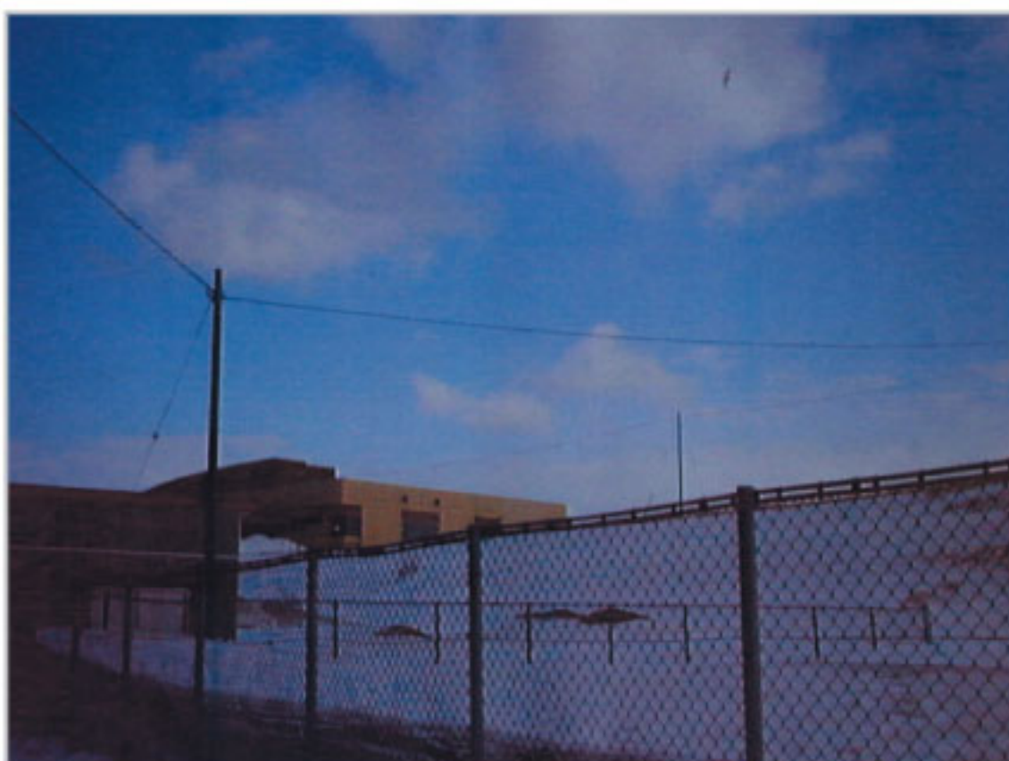
図6 稚内北星(中央)と潮見が丘中学校(写真左枠外)の間に架設した、光ファイバケーブル
