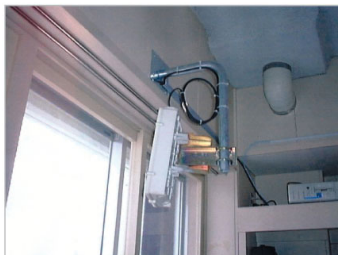
図5 稚内商工高校に向けて屋内に設置した無線LAN平面アンテナ(稚内東中学校)
