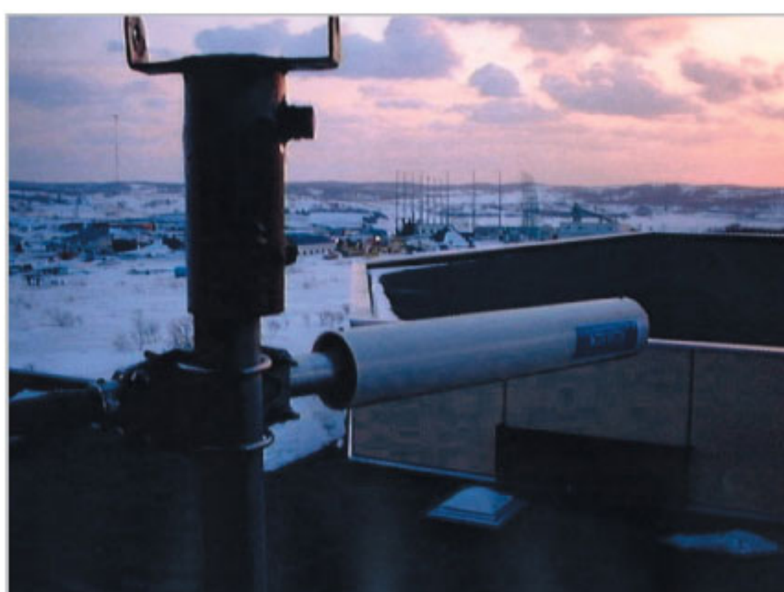
図4 稚内大谷高校に向けて屋外に設置した無線LAN八木アンテナ(稚内北星)
