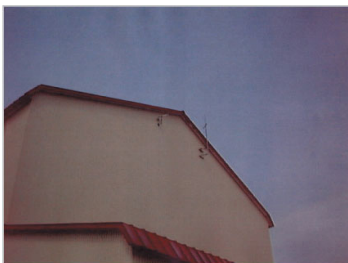
図3 稚内大谷高校の雨天練習場に設置した中継アンテナ 左側が稚内北星向け、右側が稚内電波観測所向け
