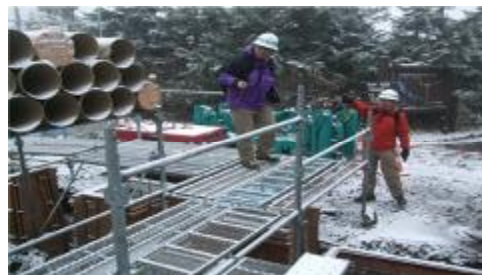
＜八幡平（八幡平市）：園路整備業務＞ 工事現場の安全パトロールをしています
