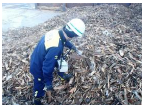
＜現地派遣職員による災害廃棄物の空間放射線量測定＞
