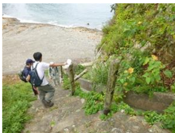
<被災状況調査（三陸沿岸の遊歩道）>
