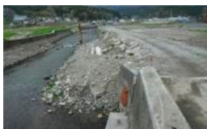
<津波で被災した河川護岸(左)と復旧工事の様子(右)>
