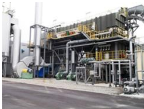
<宮古市の仮設焼却炉>
