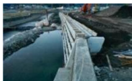
<津波で被災した河川護岸(左)と復旧工事の様子(右)>
