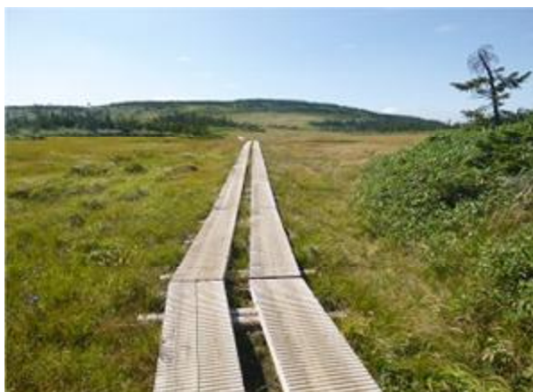
<自然公園園路整備工事完成後（八幡平）>
