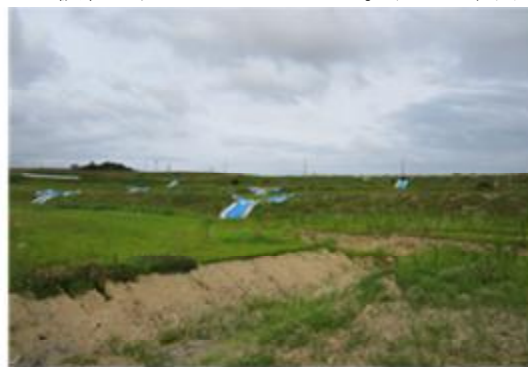
写真2 農地造成圃場の被災状況
