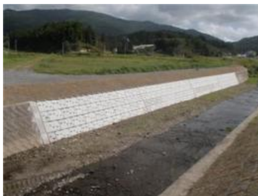
<災害復旧工事完了後>
