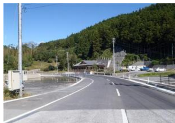
＜大船渡市赤碕町清水【復旧工事後】＞
