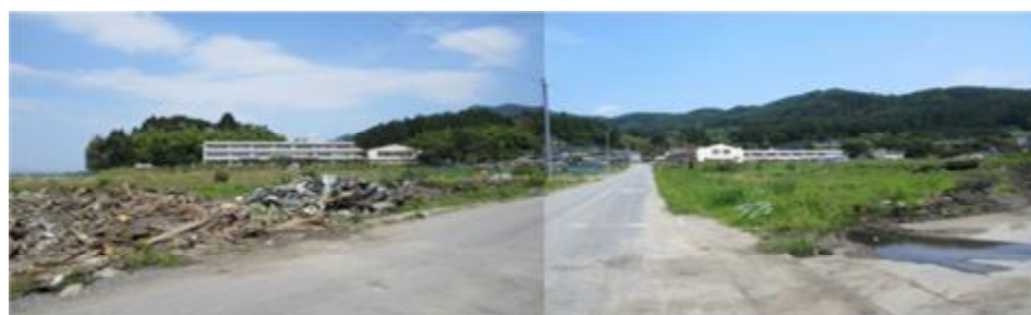
写真4 陸前高田市の被災状況
