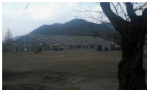
大槌町、被災した大槌中学校庭に建設中の仮校舎
