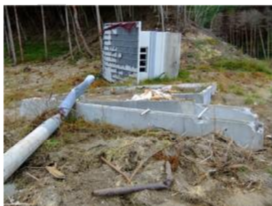
<被災したトイレ（宮古市田老地区）>
