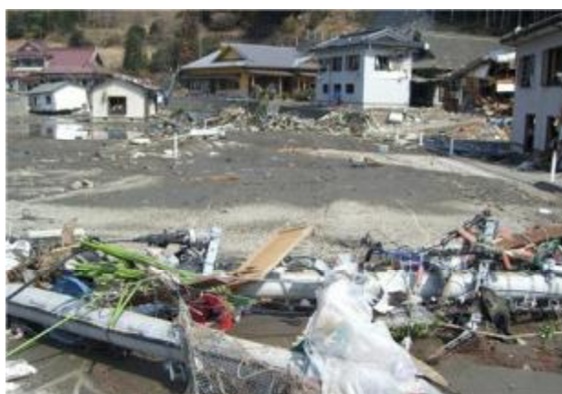
＜大船渡市赤碕町字清水【復旧工事前】＞
