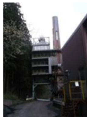
<釜石市の仮設焼却炉>
