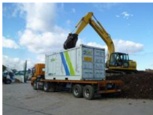
＜コンテナへの積み込み（H24.11.14・15）＞
