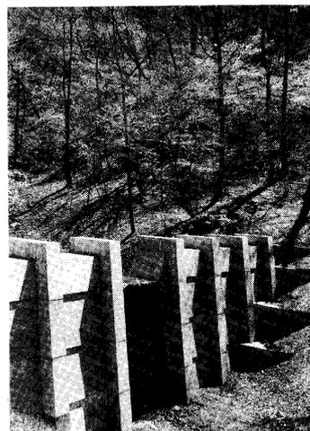
写真—3.1 環境との調和をめざした治山ダム（群馬県あずさ沢）。シンプルな重力式コンクリートダムが主体である治山ダムの無表情さを解消するために、形を洗練させることにより周囲の森林と調和をめざした景観デザインを試みている。
