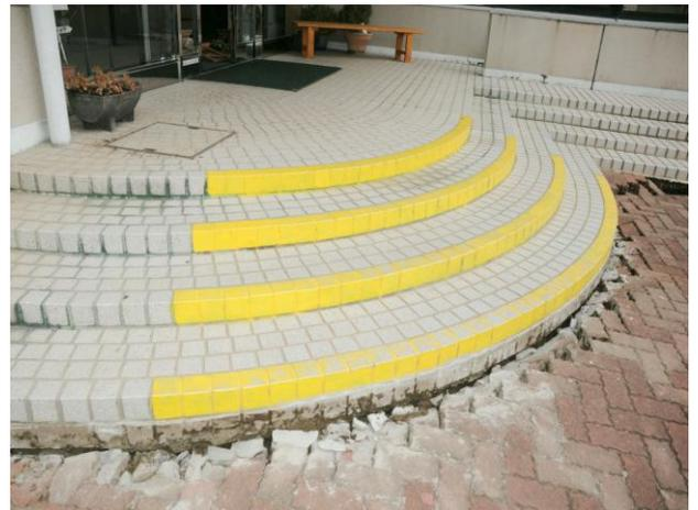
(地盤沈下したインターロッキング（南玄関前）)
