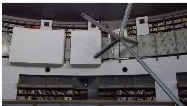
(倒壊し2階部分に食い込んだ照明灯)
