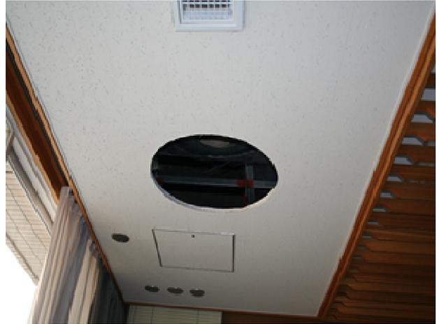
(研修室の天井の様子：通気口が抜け落ちた部分)
