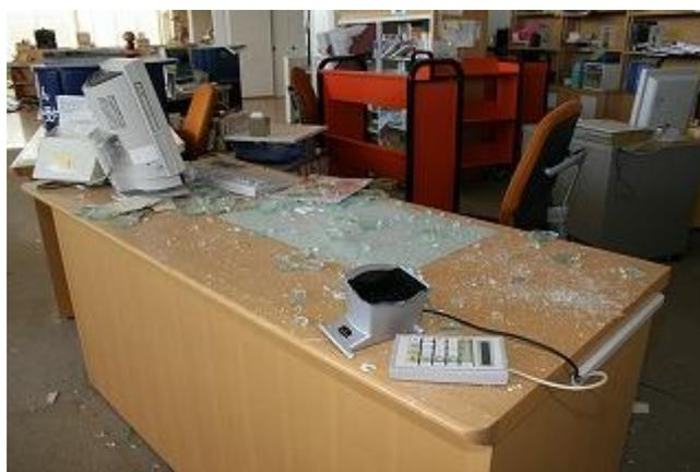
（排煙垂壁ガラス落下によるカウンター破損）
