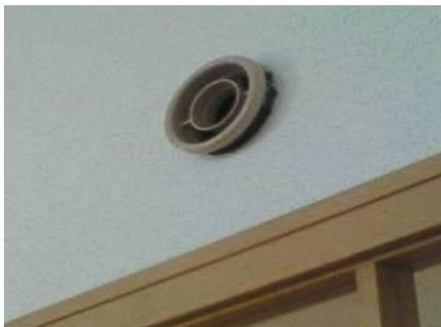
(空調の吹出口が飛び出している)
