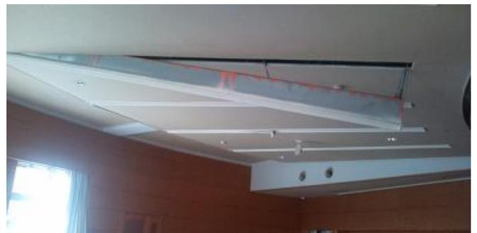
(写真3 2階視聴覚室天井の被害 2)
