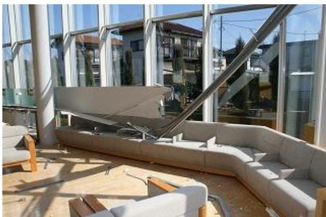
(一般開架天井材落下による閲覧席破損)
