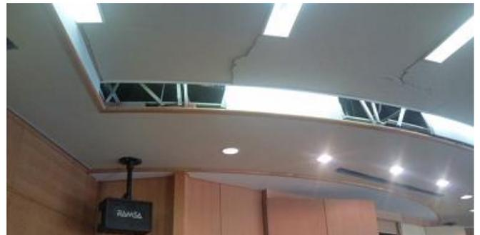
(写真2 2階視聴覚室天井の被害 1)
