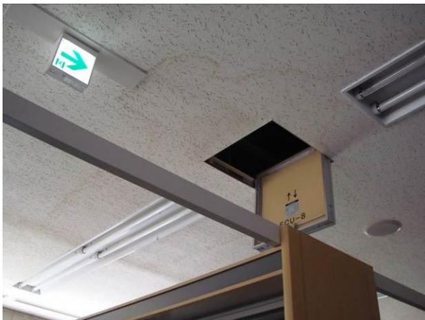
(2階エアコン用配管からの水漏跡の様子)
