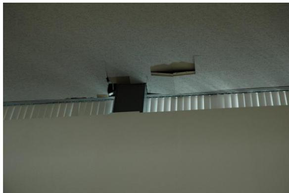
(天井石膏ボード破損の様子)
