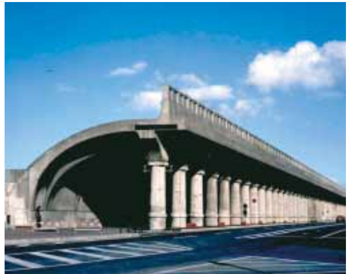
サハリン航路の発着場であった歴史的港湾構造物「北防波堤ドーム」(稚内港)
