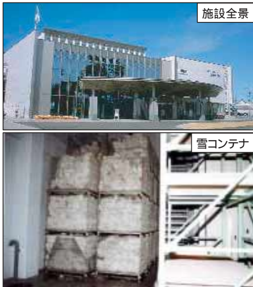
(図2) 雪氷冷熱を利用した施設冷房の事例
