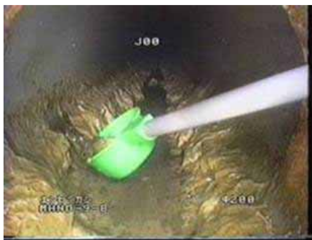
写真 4.3.6 管渠内付着物の採取状況
