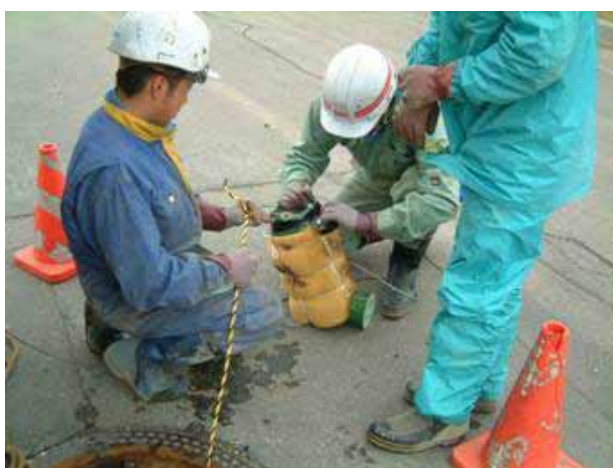
写真 4.3.1 管渠内固形物の採取作業
