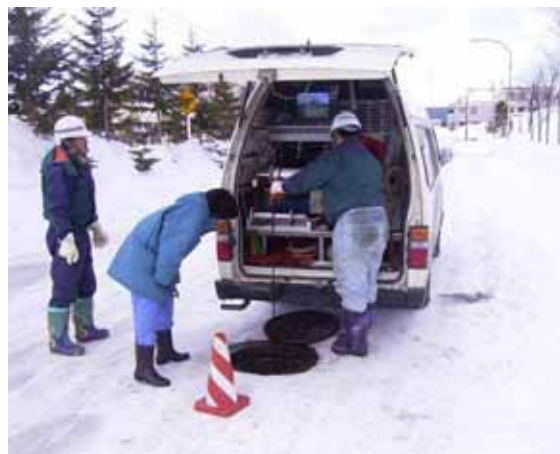
写真4.2.1 TVカメラ調査作業状況
