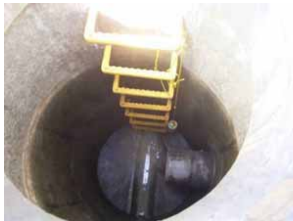
写真 4.8.1 拡散式硫化水素測定器の設置状況
