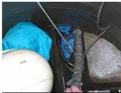
写真 4.5.1 勾配測定（水位測定器）の状況
