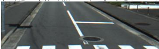
車線と路肩との境界が路面の色彩で明確であり、車道外側線が省略された例
