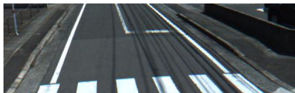
車道外側線が設置されている例
