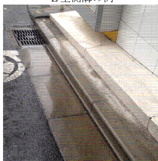
L型側溝の例
