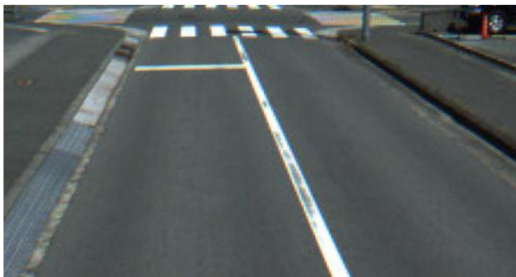
図 23 車線と側溝の境目を区画線と誤って取得しやすい例
