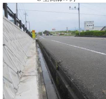
U型側溝の例
