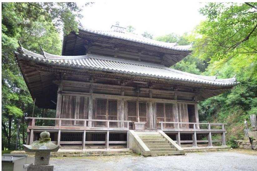
一乗寺常行堂（加西市） 明治10年の寺院建築
