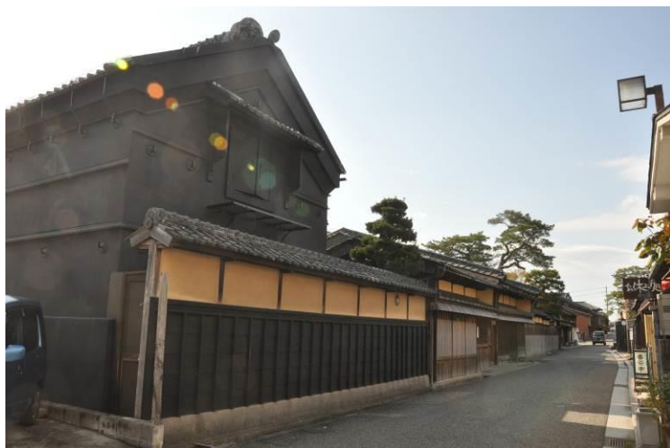
長谷川家住宅主屋魚町通り側外観
