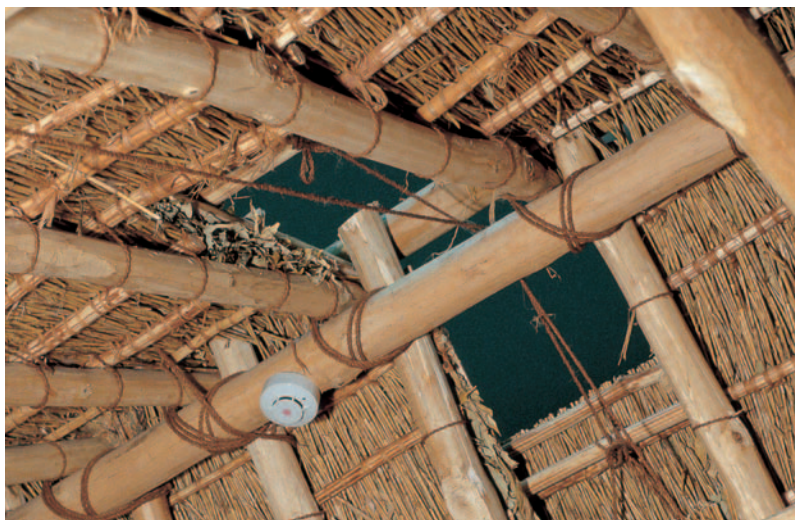
写真17 天窓（内側から屋根裏を見上げたようす）
