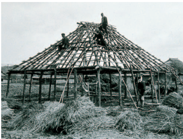
写真11 骨組みのようす（白老町：大正から昭和の初めごろ）
