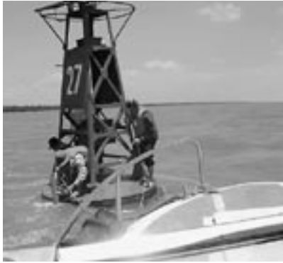
図8 メコン川航路浮標への塩分計設置作業。
