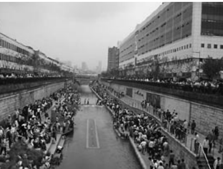
図 13 復元された清溪川に繰り出したソウル市民(2005年10月1日)。
