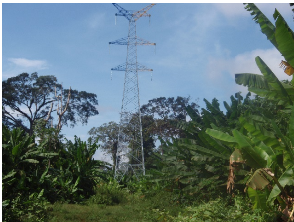
図7 水力発電ダム開発下で森を縦断する形で建てられた電波塔の一つ。
