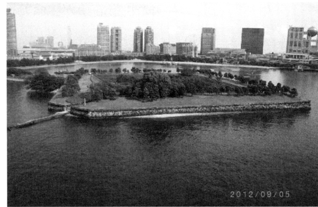
写真一 現況の第三台場
