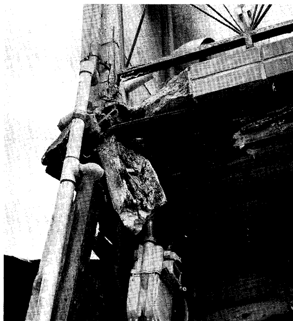
写真2 木造2階テラス部分横架材の腐朽
