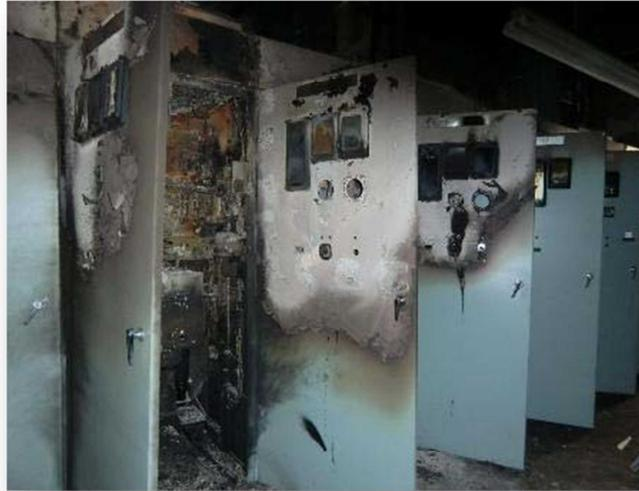
図2. 1 女川1号機の高圧電源盤のHEAFによる損傷状況<sup>(参7)</sup>
