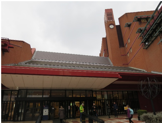
セントパンクラス館外観。セントパンクラス駅隣。
