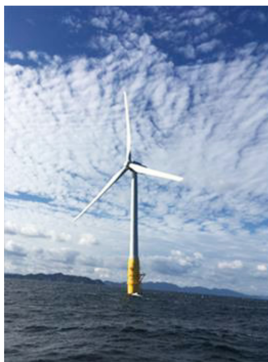
図 崎山沖 2MW 浮体式洋上風力発電所
