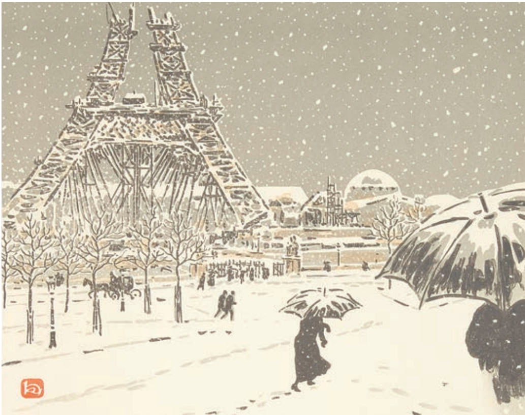
La Tour en construction, vue du Trocadéro (建設中のエッフェル塔、トロカデロからの眺め)
