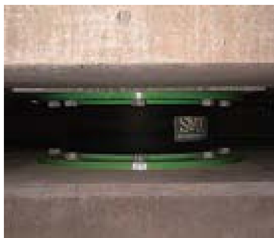
(図2) 積層ゴムアイソレーター
