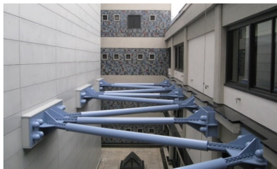
(図9) 書庫棟と事務棟をつなぐ鉄骨ブレース
