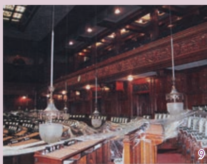
9 掃除や電球交換を行う際はペンダント灯がワイヤーで下ろされる。 10 LED電球が使われている。 衆議院事務局 編『国会議事堂新ガイドブック 移りゆく白亜の議事堂』衆栄会 2017<請求記号 KA272-L26>
