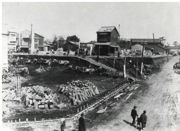
▲ 昭和3年 中野駅北口広場拡張工事 [提供：中野区]
