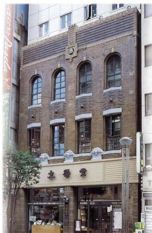
▲ 外壁補修直後の文房堂外観(2003年)
