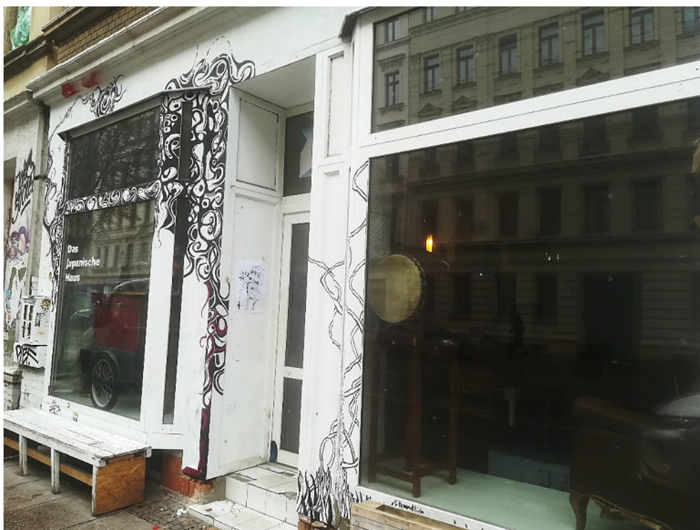
写真3 「家守の家」プロジェクトを活用した空き家の改修例
